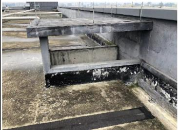
在屋顶风井洞口安装百叶封闭，避免坠落风险。 |
